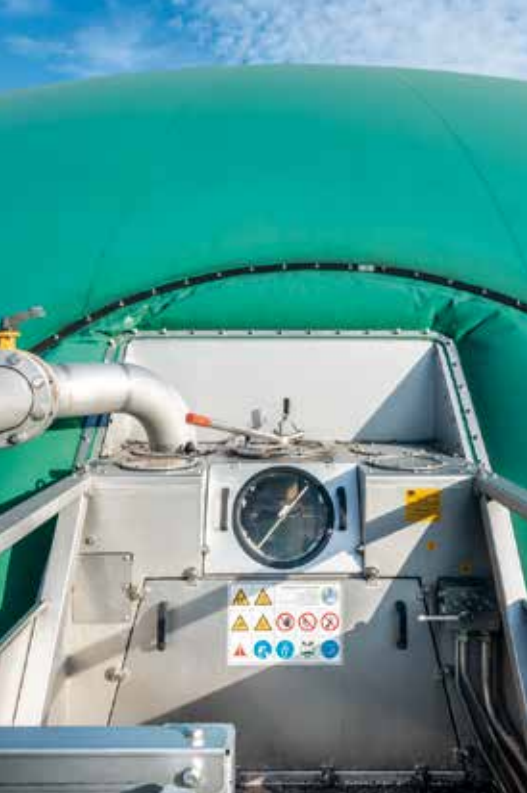
Servicebox Pro mit Gasabgang im Gärrestlager
